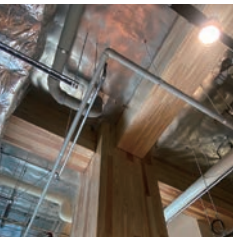
DBで参加した大林組の開発によるプレキャストSRC仕口。大部分を工場で木柱とあらかじめ一体化することにより精度確保・環境負荷低減を図った。
