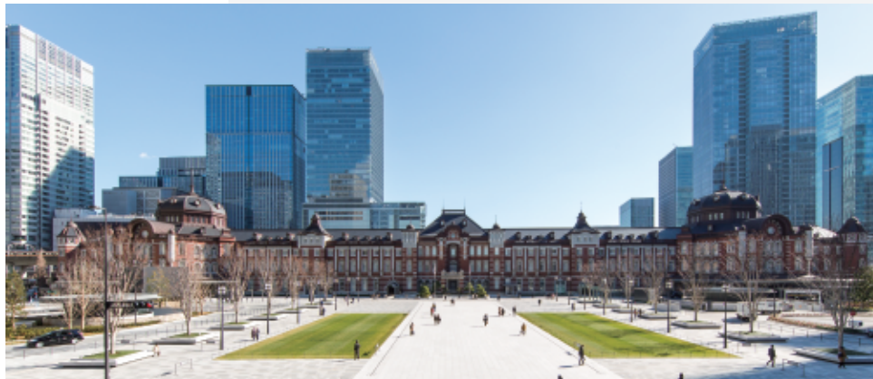
東京駅丸の内駅舎保存・復原
