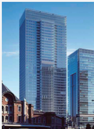
グラントウキョウ サウスタワー
