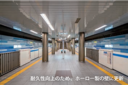
天井・壁・床の改修、案内室の更新を行った改札口周辺
